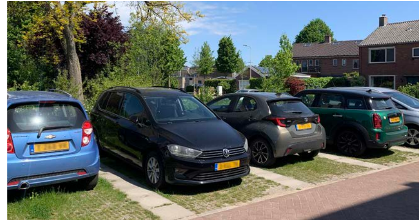
voorbeeld: gebruik van halfverharding bij parkeerplaatsen
