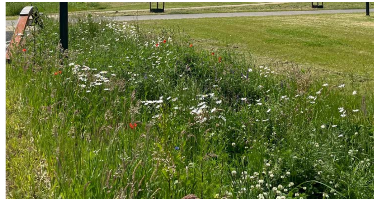
Beplante wadi's als waterretenties en infiltratie
