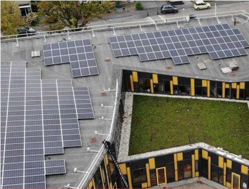
Zonnepanelen in combinatie met verhoogde dakrand
