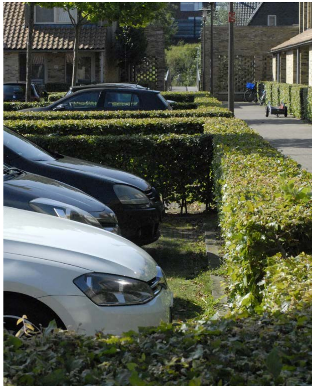
Parkeren uit het zicht en groen ingepakt
