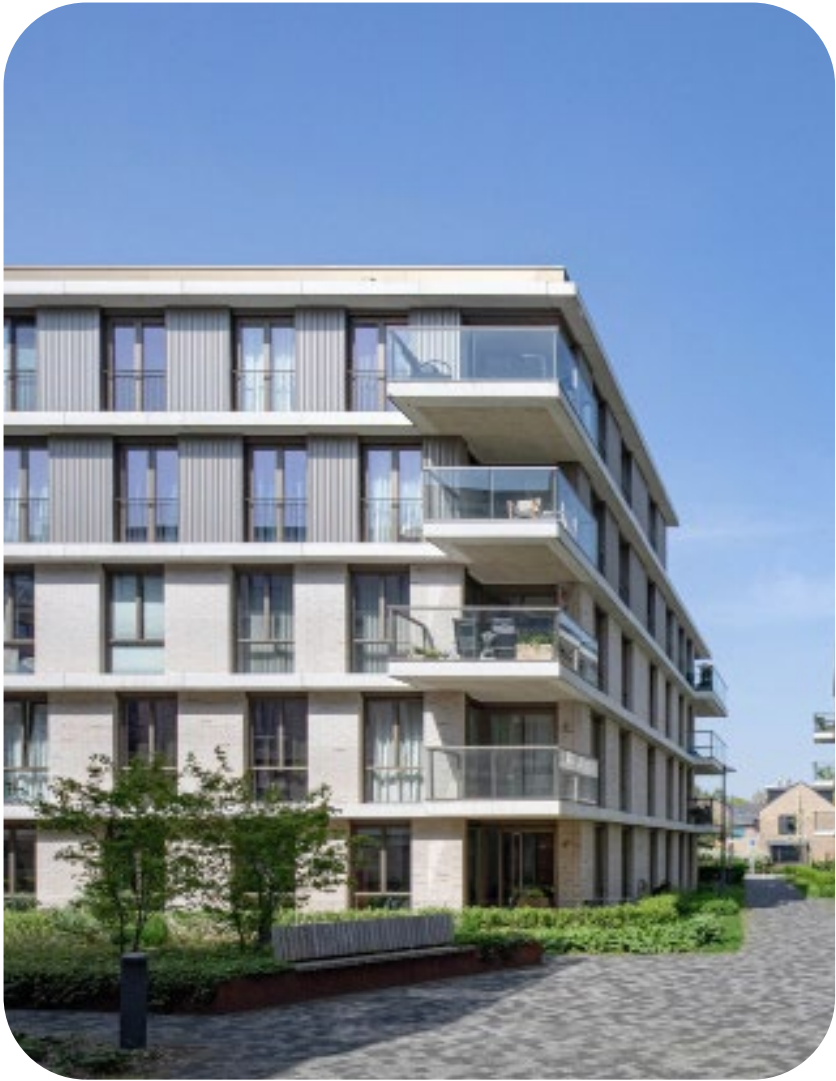
HORIZONTALE GELEDING IN COMBINATIE MET METSELWERK
