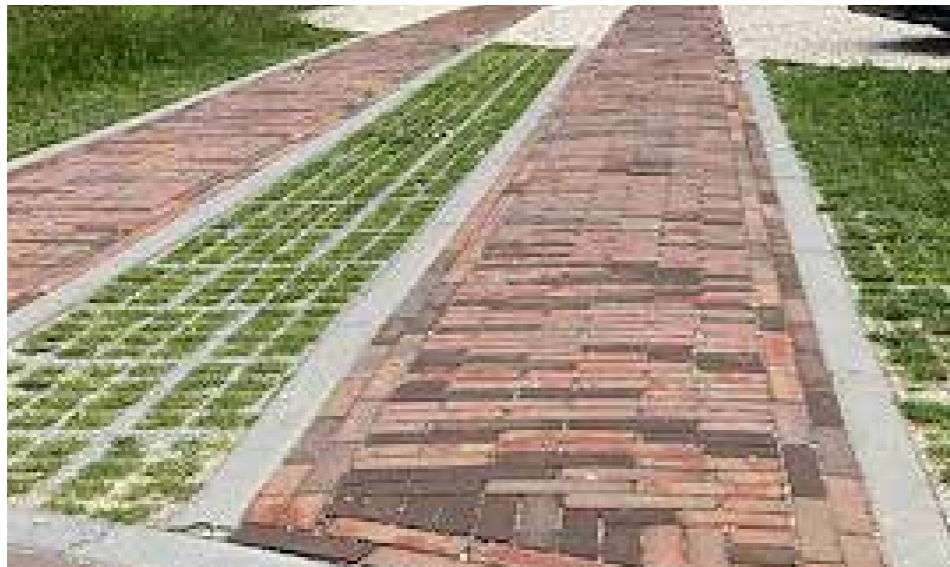
Karrespoor met in het midden half verharding dat zorgt voor infiltratie van het regenwater
